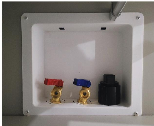
La préparation de la laveuse/sécheuse est conçue spécifiquement pour la laveuse/sécheuse empilable de marque Splendide qui a une largeur de 59,69 cm.
