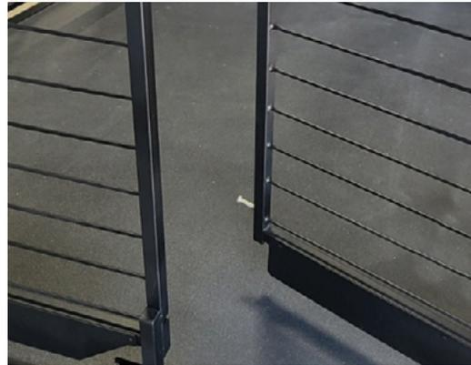
6. De là, commencez par le garde-corps se trouvant juste à gauche des marches (lorsque vous faites face au VC). Appuyez sur le loquet du pied vers le bas pour dégager le garde-corps de la fixation au sol, et faites pivoter le panneau du garde-corps jusqu'à ce qu'il rencontre le panneau du garde-corps extérieur. Vous devrez appuyer sur la partie inférieure du panneau pour vous assurer qu'il touche l'aimant de fixation. Vous entendrez lorsque la jonction sera établie.
