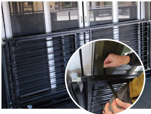
4. En commençant par la première partie se trouvant le plus à l'extérieur du garde-corps de patio, faites pivoter soigneusement le garde-corps vers le bord de la porte rampe.
