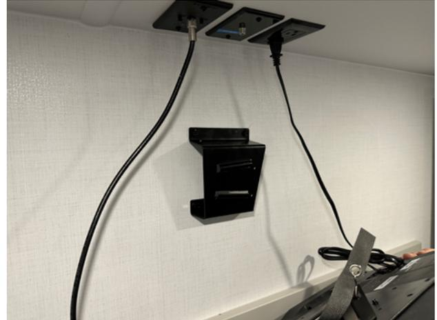
Pour remettre le téléviseur en place, alignez la patte en forme de « V » se trouvant à l'arrière du téléviseur, sur les rainures correspondantes se trouvant sur la patte murale. Faites glisser le téléviseur vers la gauche jusqu'à ce que vous entendiez un clic du loquet de la patte du téléviseur et réenclenchez-le. À ce stade, le téléviseur est désormais fixé à la patte murale.
